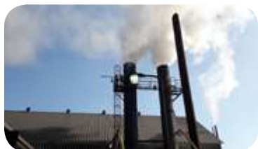
Monitoreo ambiental Emisiones de gases chimeneas en Ingenios
